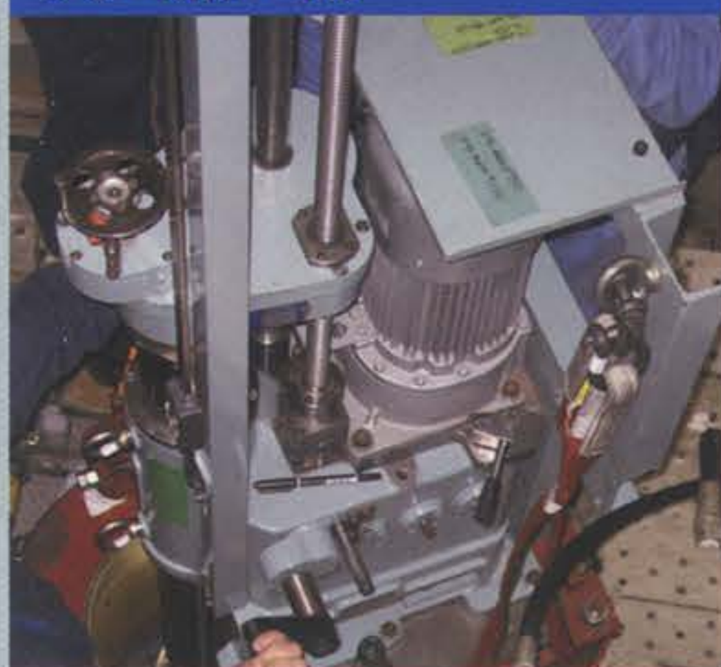
■ステライト肉盛後のシートリング仕上加工
